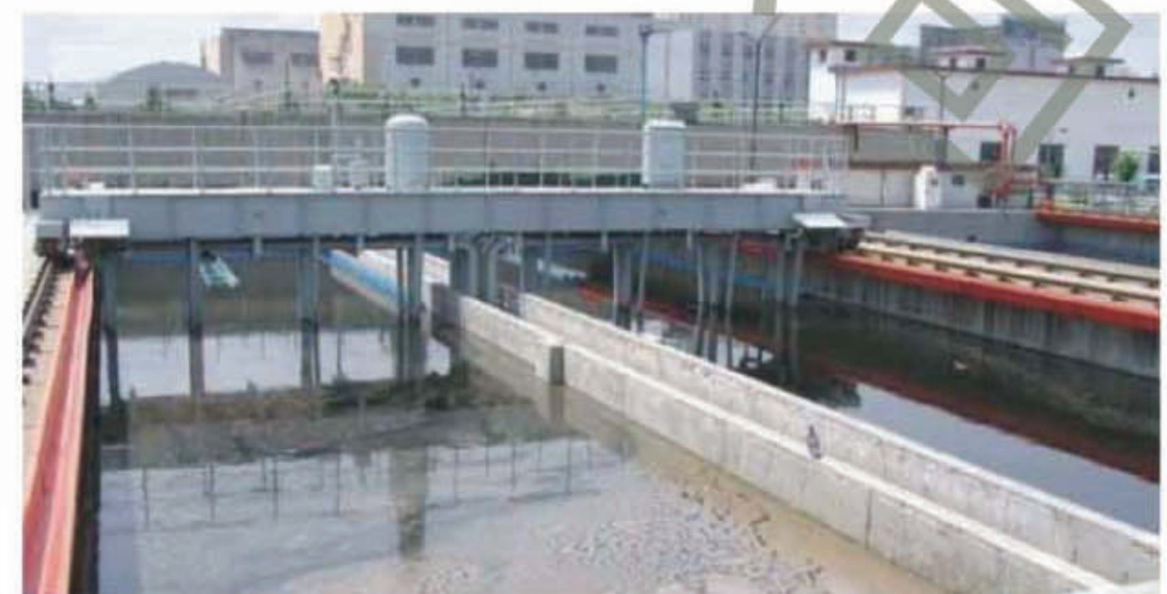
1、传动装置 2、主梁 3、吸泥系统 4、支架 5、电控系统 6、轨道 7、输电装置
